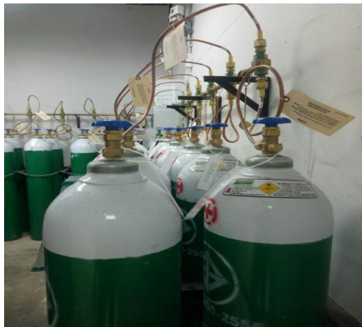
รูปที่ 3.3 ลักษณะเส้นท่อจากท่อบรรจุหรือหางหมู
